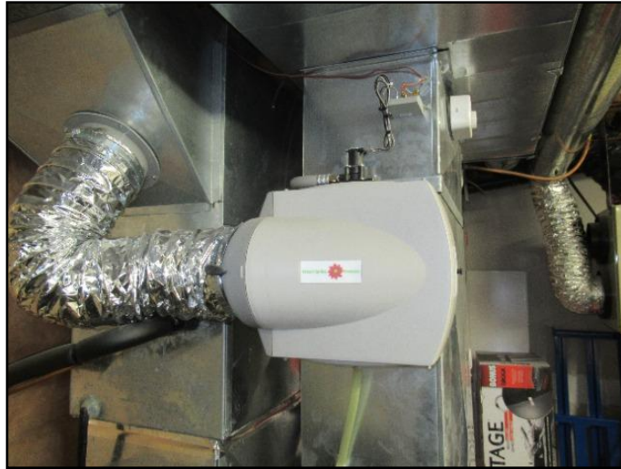
26. Trickle/cascade type humidifier
