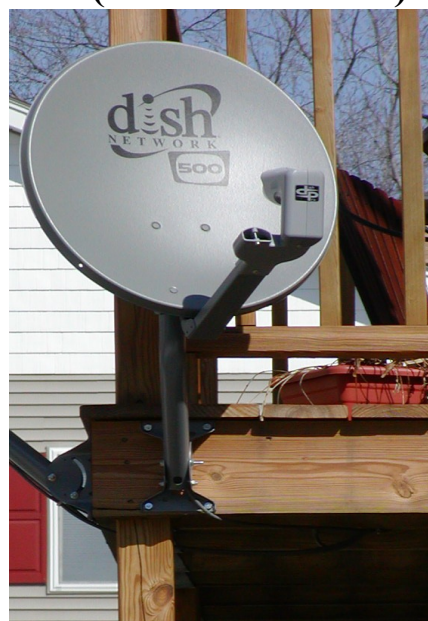
Correct (all wires hidden)
