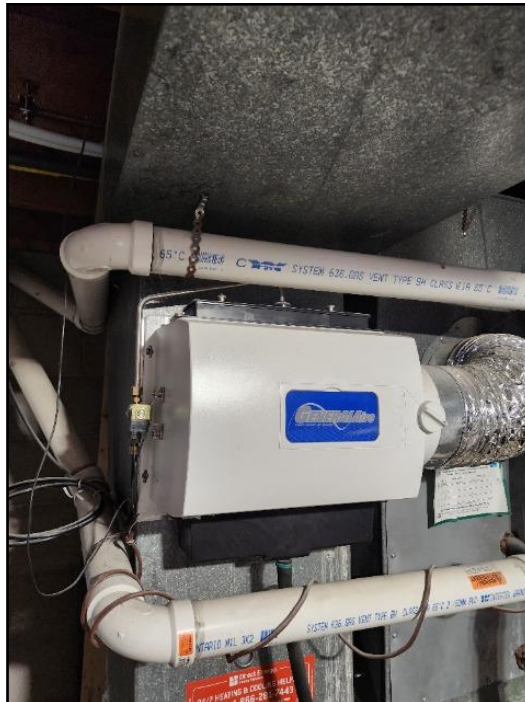
16. Trickle/cascade type humidifier
