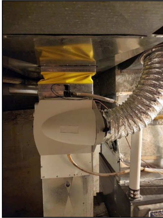
25. Trickle/cascade type humidifier
