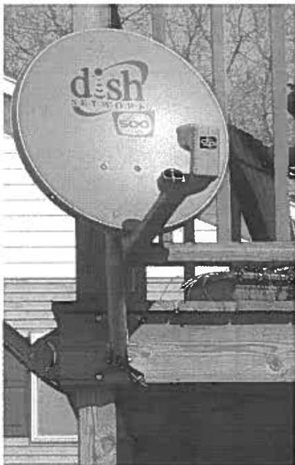
Correct (all wires hidden)
