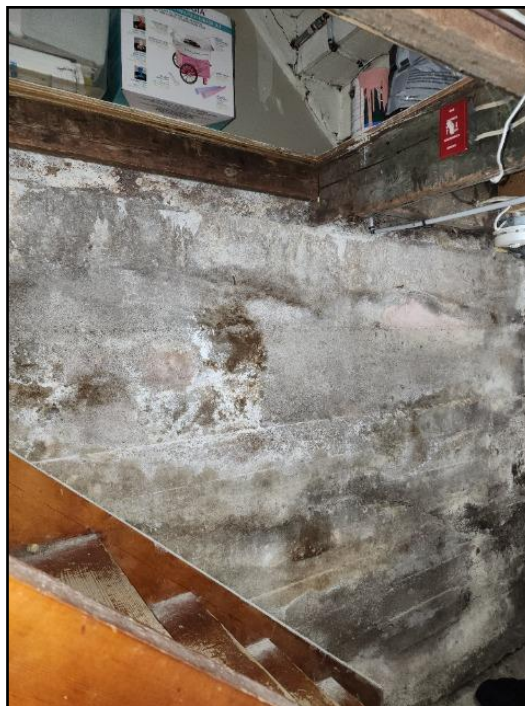
23. Efflorescence
