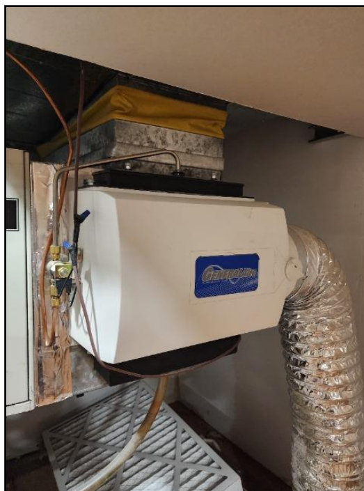
19. Trickle/cascade type humidifier
