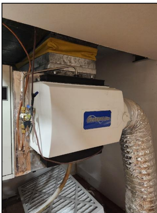
19. Trickle/cascade type humidifier
